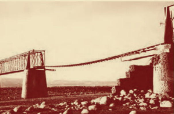
Un cyclone a emporté une trouée mais les rails ont réédité et pendent dans le vide, [années 1960]
