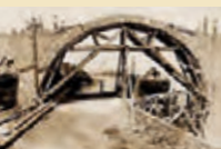
Montage d'une arche du pont de la Grande Ravine (J. Adrien Blondel), [1878-1882]. Bibliothèque de géographie, 100 02 01 02
