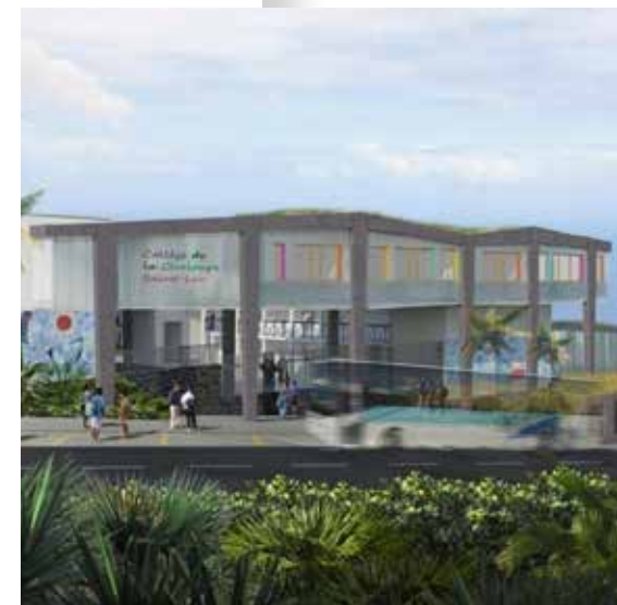
Collège la Chaloupe Saint-Leu : Coût d'opération : 11,175 M€
