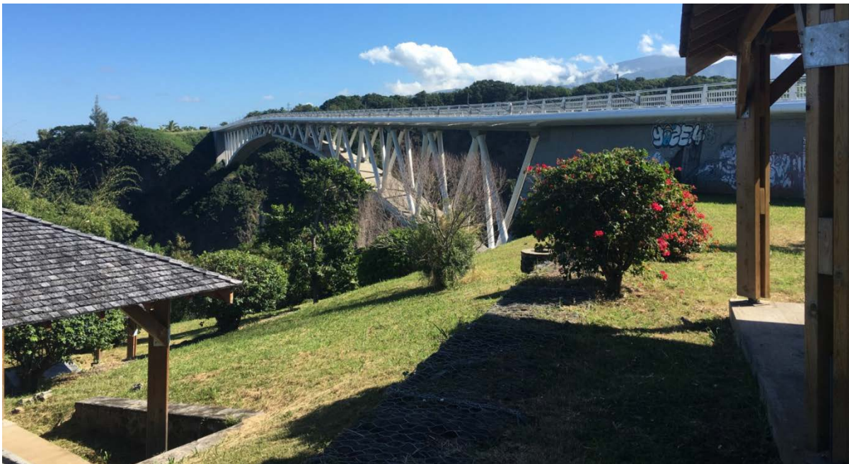
Photo : vue du pont depuis l'aire de pique nique, rive gauche.
