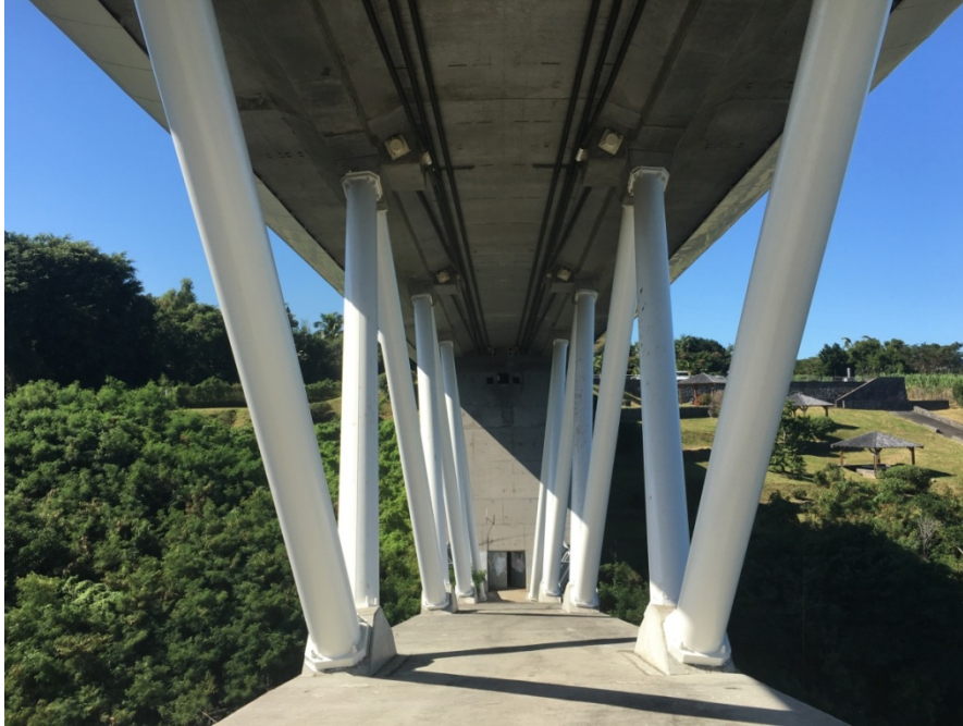
Photo : vue depuis l'arche, culée rive gauche.
