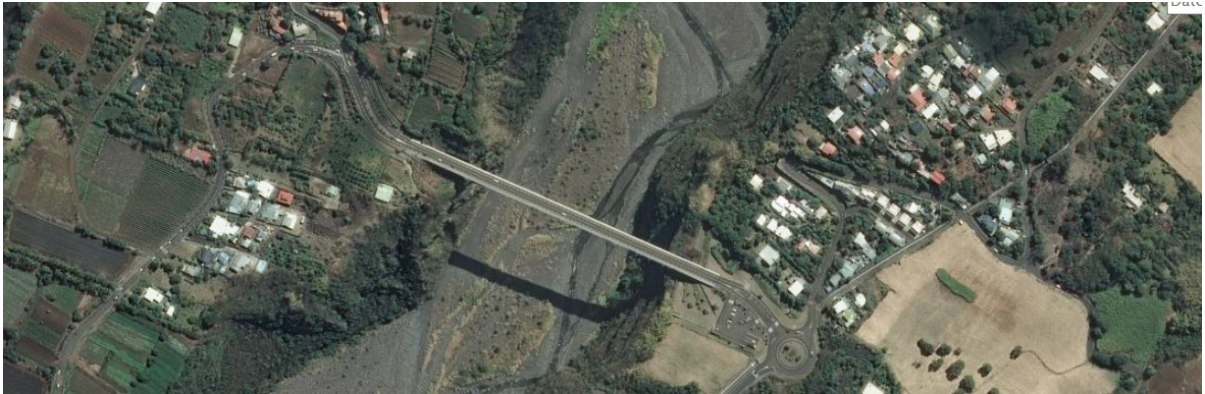
Photo aérienne du pont du Bras de la Plaine
