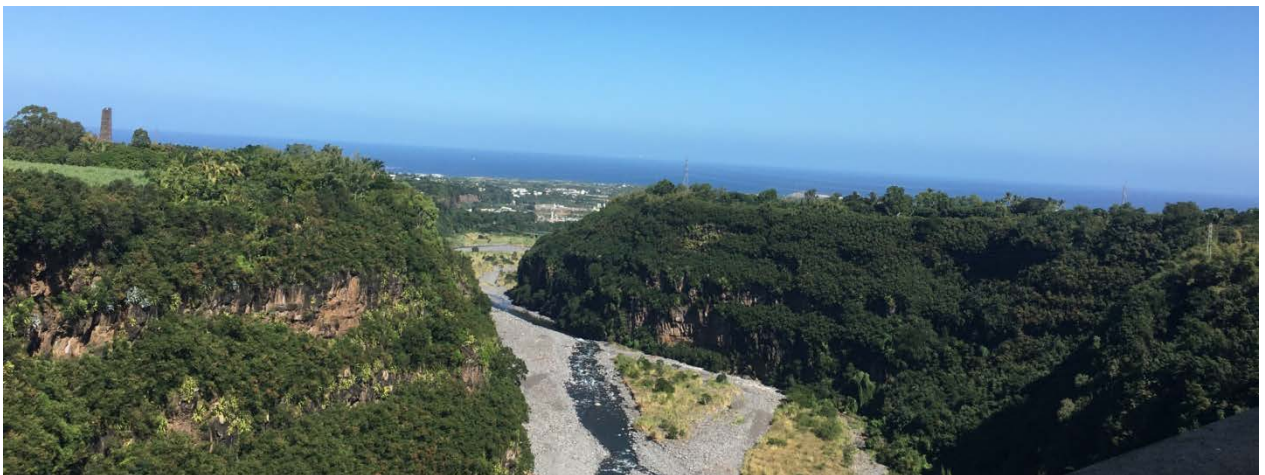
Photo : vue sur le Bras de la Plaine coté mer (vue prise depuis l'arche coté rive Gauche)
